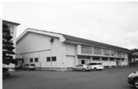
今年度耐震補強予定の峰中体育館
