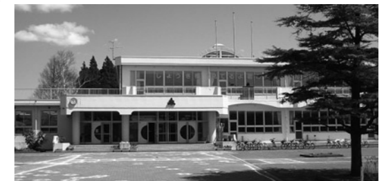
旧埴川小学校校舎
